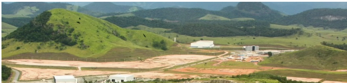
Figura 2. Vista aérea da região da obra após terraplanagem.
